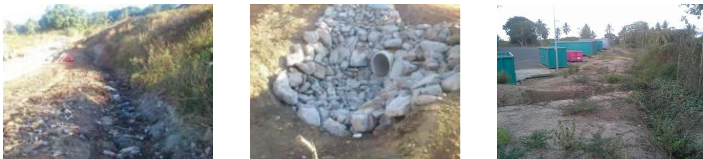
Photographie 5: Fosse EP Est (gauche), rejet dans le fossé au Sud du quai de transfert (milieu), fossé au Sud du quai de transfert (droite) (Source : ELCIMAI, Etude Diagnostic & AVP, 2014)
